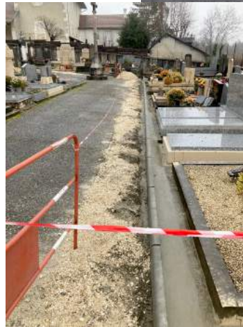
Travaux cimetière de Lompnieu
