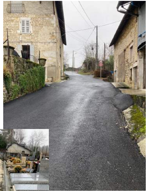
Travaux route du Pont
